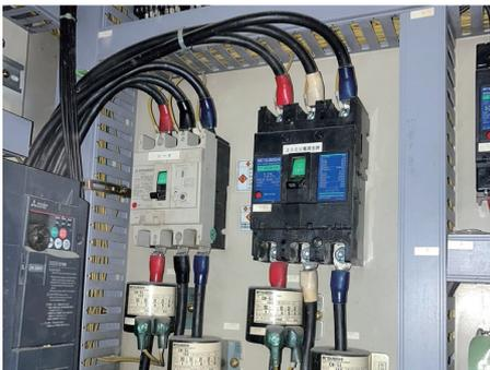
④電源切断（制御盤のブレーカー OFF）
