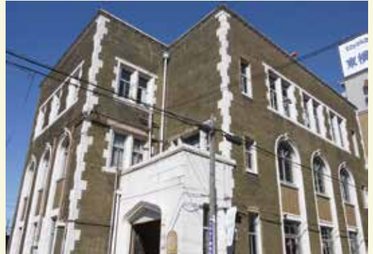
旧・尾西繊維協会ビル
